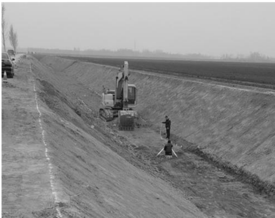
图 2-8 渠道土方开挖
