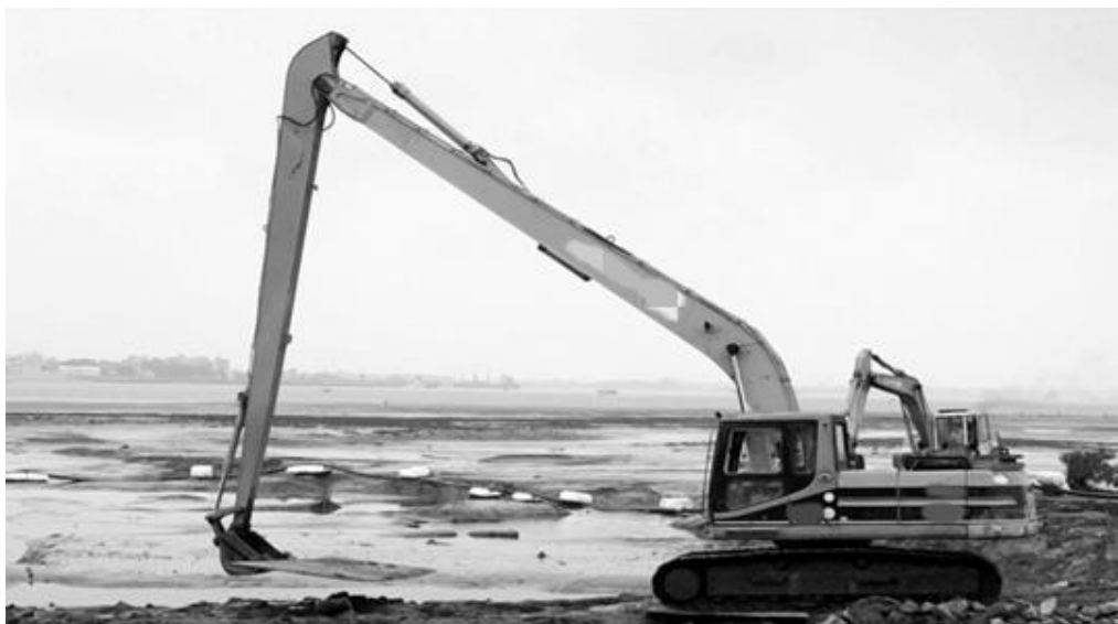
图 2-12 挖机清淤示例图
