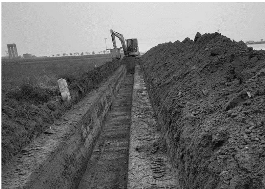
图 2-6 渠道土方开挖
